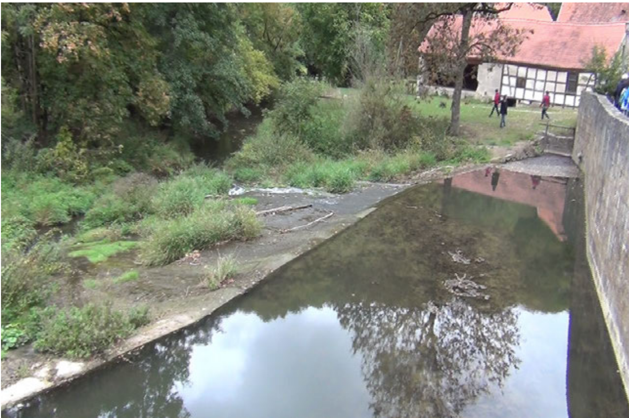
Streichwehr bei der Steinmühle
