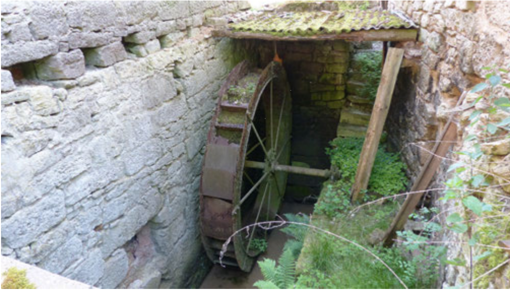
Das erhaltene der ursprünglich zwei überschlächtigen Eisenmühlräder.
