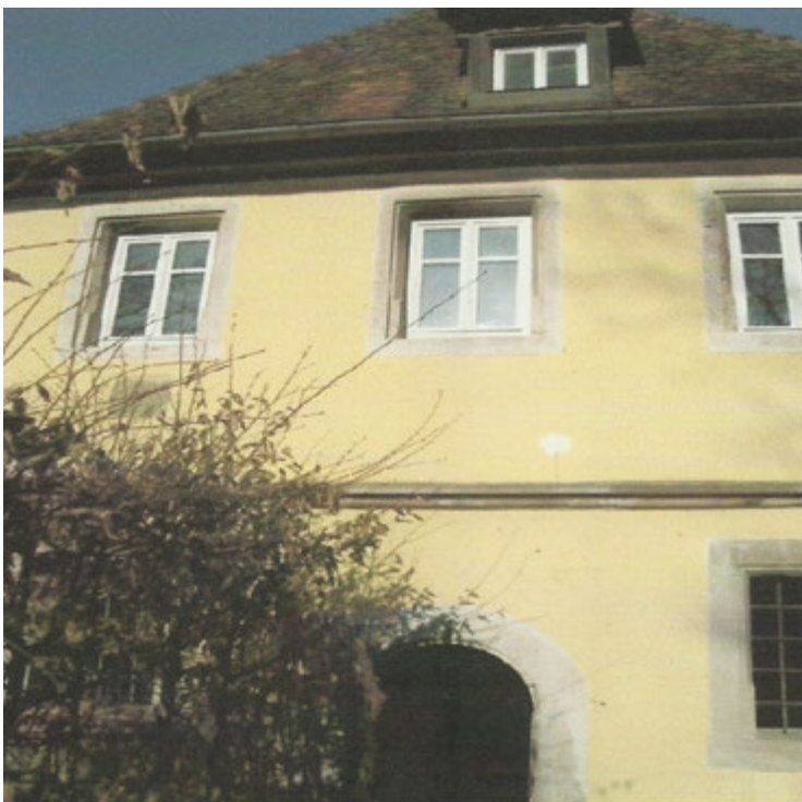
links: Das Gebäude des Brunnenwerkes.
