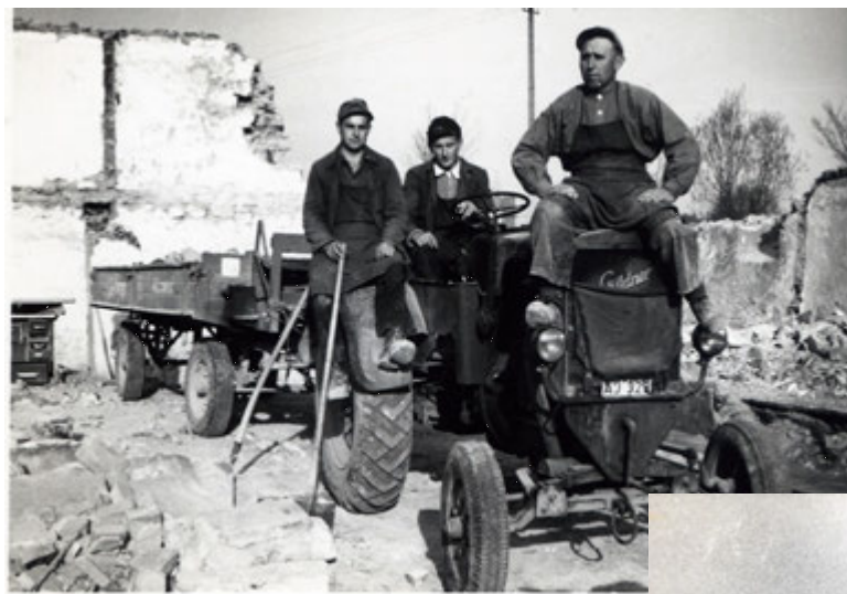
Die Stettberger Mühle vor und nach dem Abriss in den 1950-er Jahren. Fotos: Fam. Doppelhammer, Poppenbach
