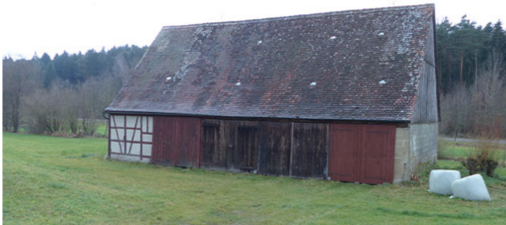
Nebengebäude der Mühle, schon bei der Uraufnahme existierend. Foto: Hm
