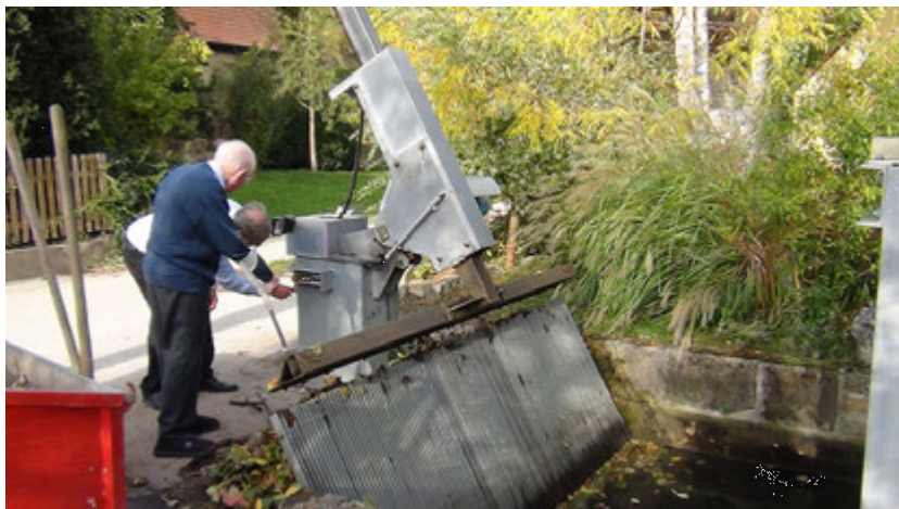
Der Rechen am Einlauf zur Mühle Fotos: P-Seminar II
