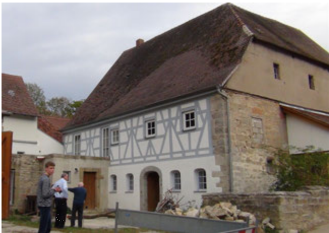
Teilansicht der Weißenmühle
