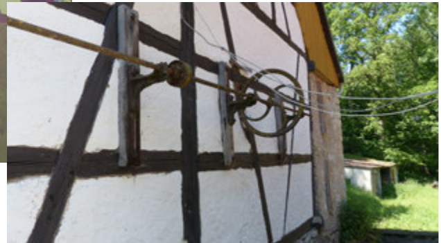
Fachwerk der Rückseite der Scheune
