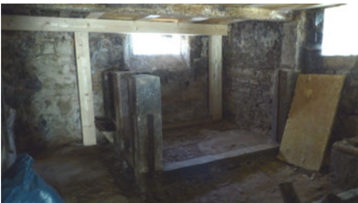
Der Stall im Untergeschoss der Mühle.
