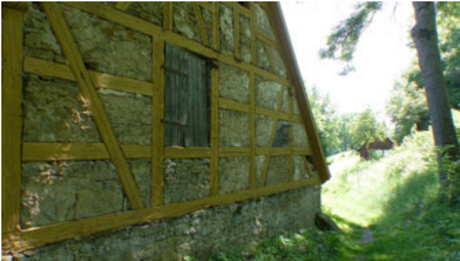
Seitenansicht der Scheune: das Fachwerk ist mit Muschelkalksteinen ausgemauert.
