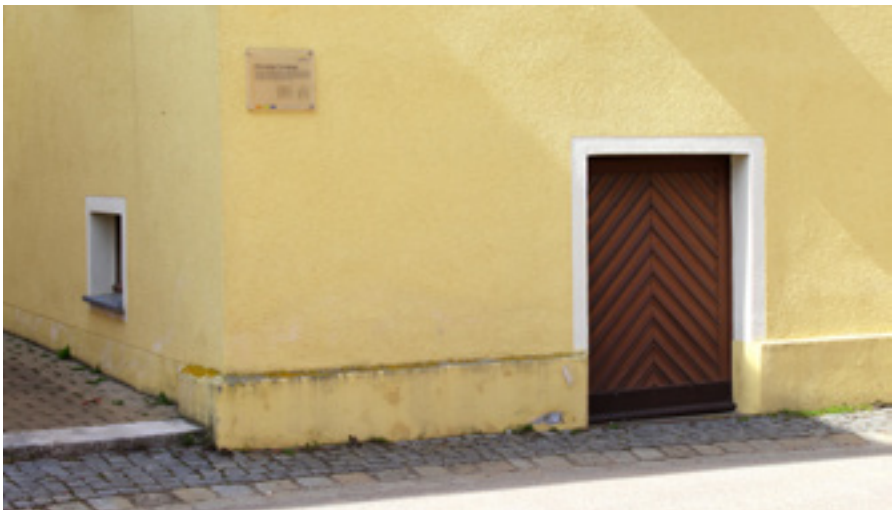
Ehemalige Synagoge Kappelgasse 38
