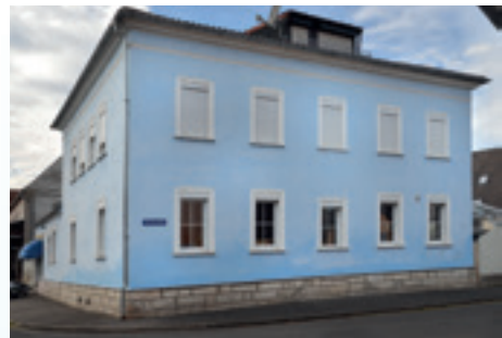
Ehem. Jüdische Schule Uehlfeld
