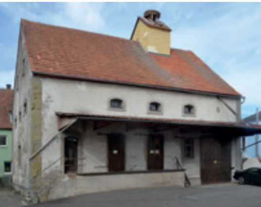
Ehem. Synagoge Uehlfeld
