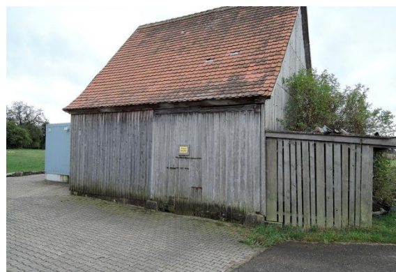
Die Dorfscheune im aktuellen Zustand
