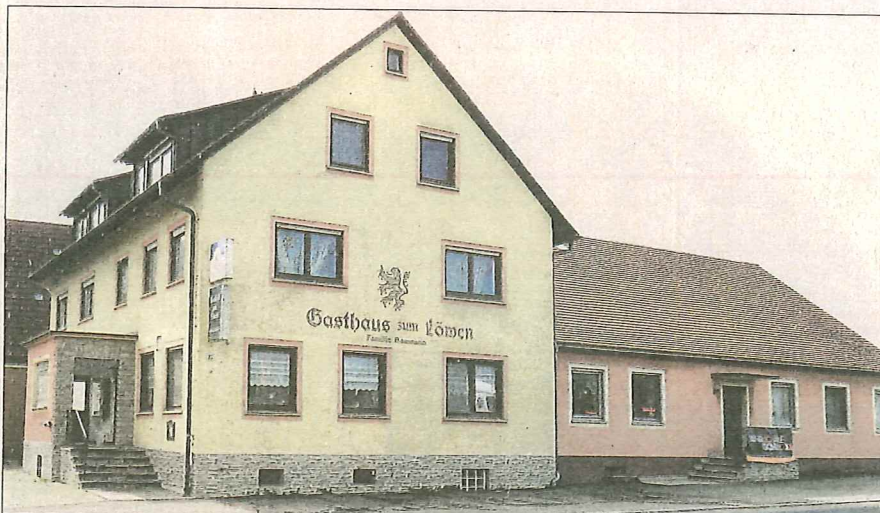
Die alte Gastwirtschaft in Oberscheckenbach soll zum Dorfgemeinschaftshaus werden. Für dessen Einrichtung kann die Gemeinde Ohrenbach eine LAG-Förderung einplanen. Archivfoto: Karl-Heinz Gisbertz
