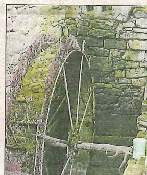
Das eiserne Mühlrad muss ersetzt werden. Foto: Simone Hedler
